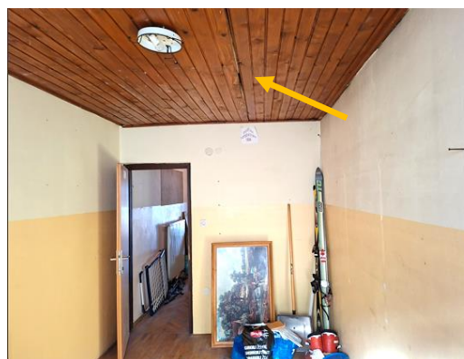
SAMOSTI PROSTOR št.5 – odstopanje stropne obloge zaradi zamakanja
