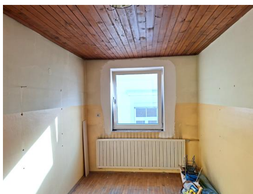
SAMOSTI PROSTOR št.5 – odstopanje stropne obloge zaradi zamakanja
